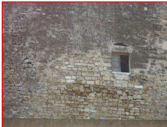
Fig. nr. 15: Dettagli prospetto Nord (assenza di malta di allettamento e di elementi del tessuto murario)
