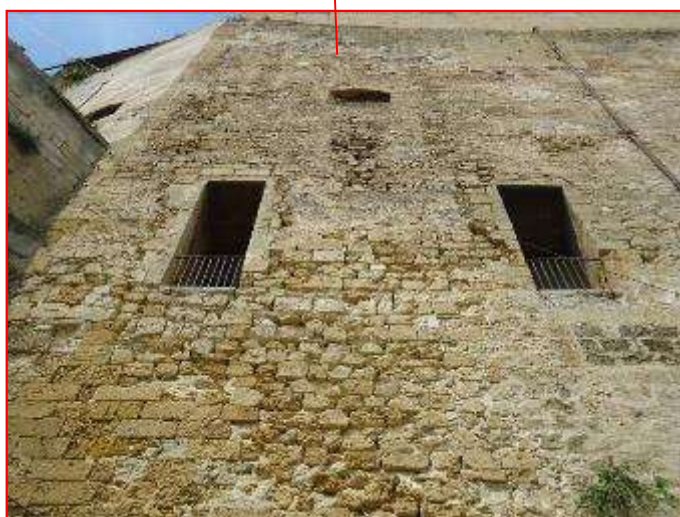
Fig. nr. 12: Dettaglio prospetto Est (assenza di malta di allettamento e di elementi del tessuto murario)
