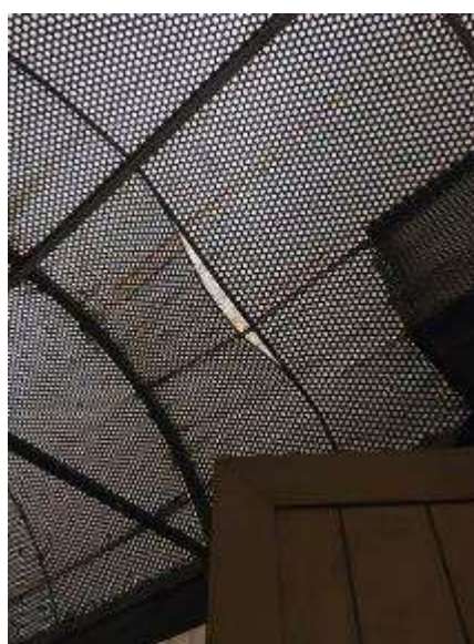
Fig. nr. 11: Struttura in profilati metallici realizzata a protezione dell'area di passaggio e danno cagionato alla copertura metallica dall'elemento lapideo caduto
