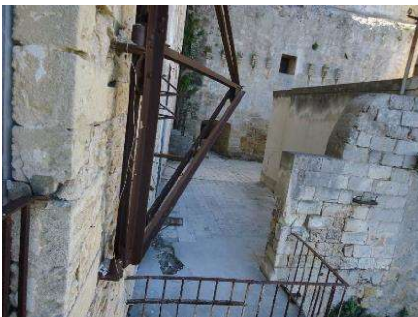
Fig. nr. 24: Prospetto lato ovest, particolare della gruetta metallica vincolata alla muratura
