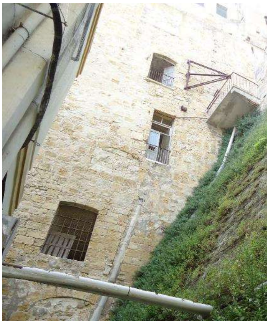
Fig. nr. 22: Porzione del prospetto Lato Ovest-Condotta di scarico fognario in cemento amianto
