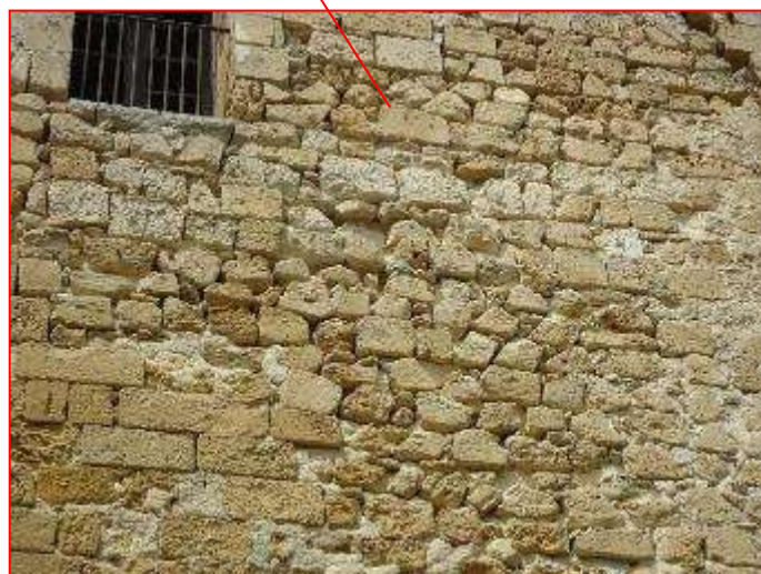
Fig. nr. 13: Prospetto Est (assenza di malta di allettamento e presenza di malta cementizia sui paramenti murari)
