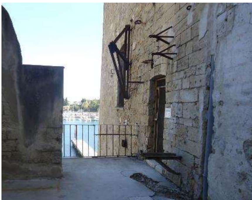
Fig. nr. 23: Porzione del prospetto Lato Ovest - Aggetto in c.a. e gruetta metallica vincolata alla muratura
