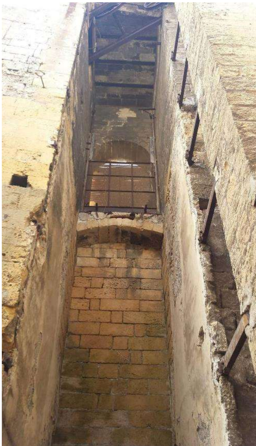
Fig. nr. 34: Vano elevatore dell'ex ascensore siluri e munizioni
