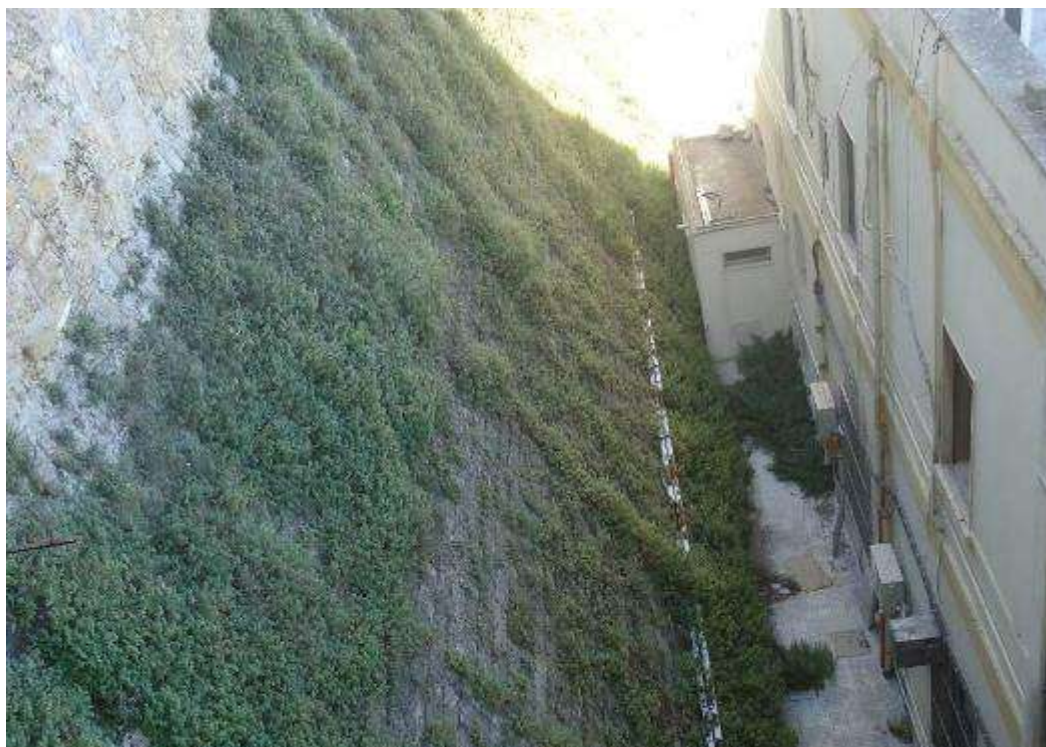
Fig. nr. 26: Muro di cinta lato ovest, assenza di malta tra i conci e presenza di fitta vegetazione
