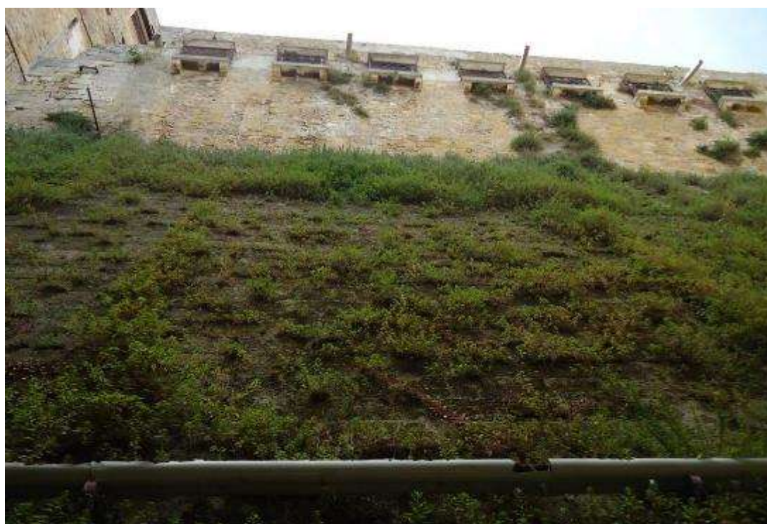
Fig. nr. 25: Muro di cinta lato ovest, assenza di malta tra i conci e presenza di fitta vegetazione
