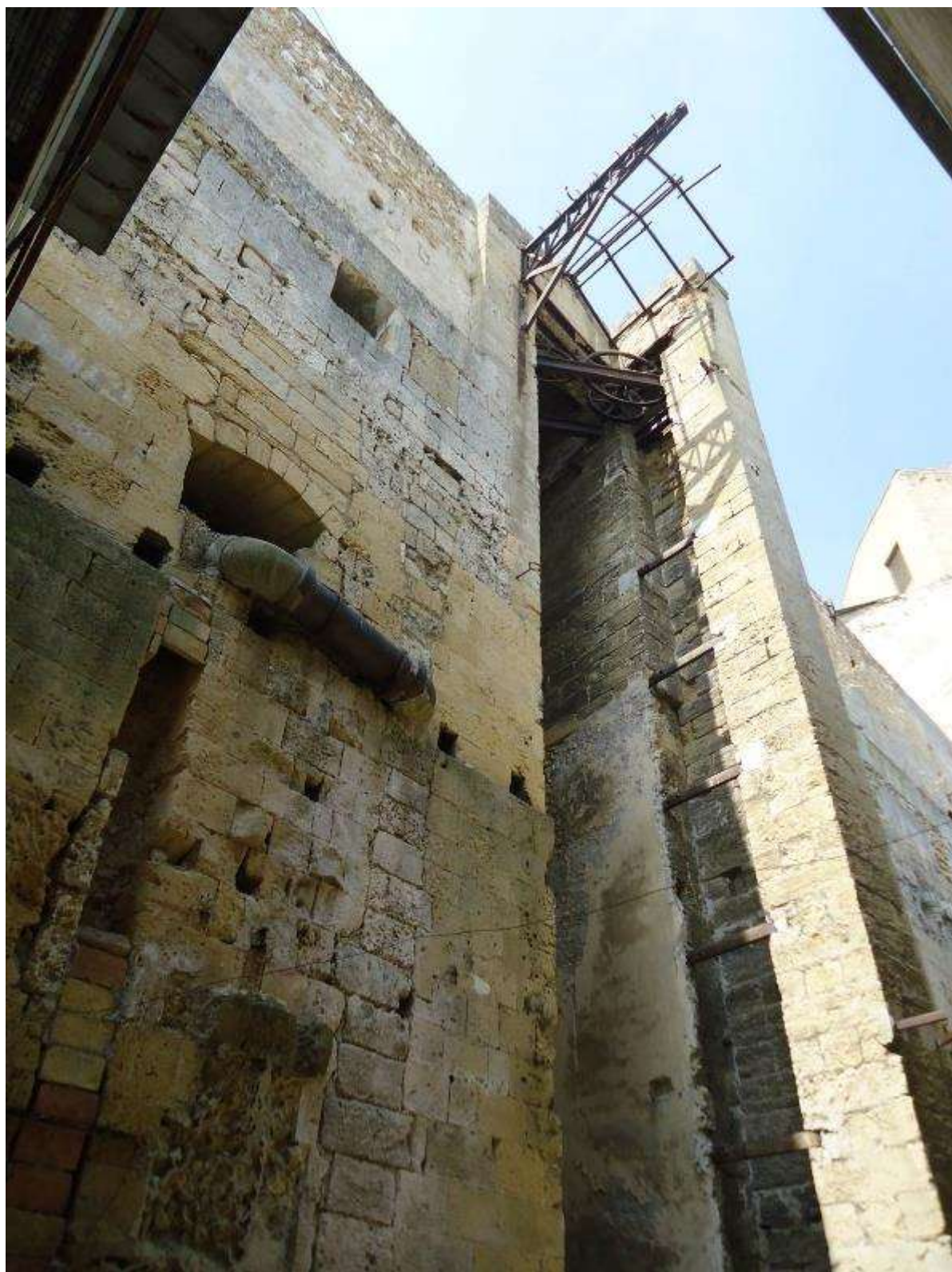
Fig. nr. 30: Mura di cinta lato Est - Vano elevatore dell'ex ascensore siluri
