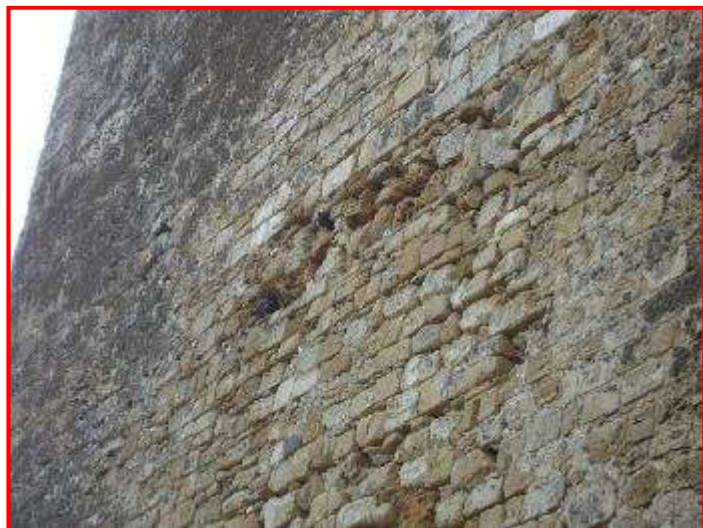
Fig. nr. 15: Dettagli prospetto Nord (assenza di malta di allettamento e di elementi del tessuto murario)
