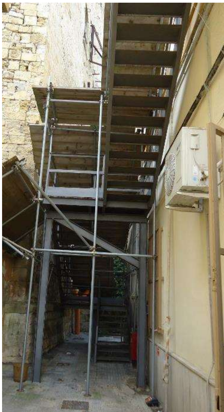
Fig. nr. 21: Prospetto Ovest, opere provvisorie a protezione della scala antincendio
