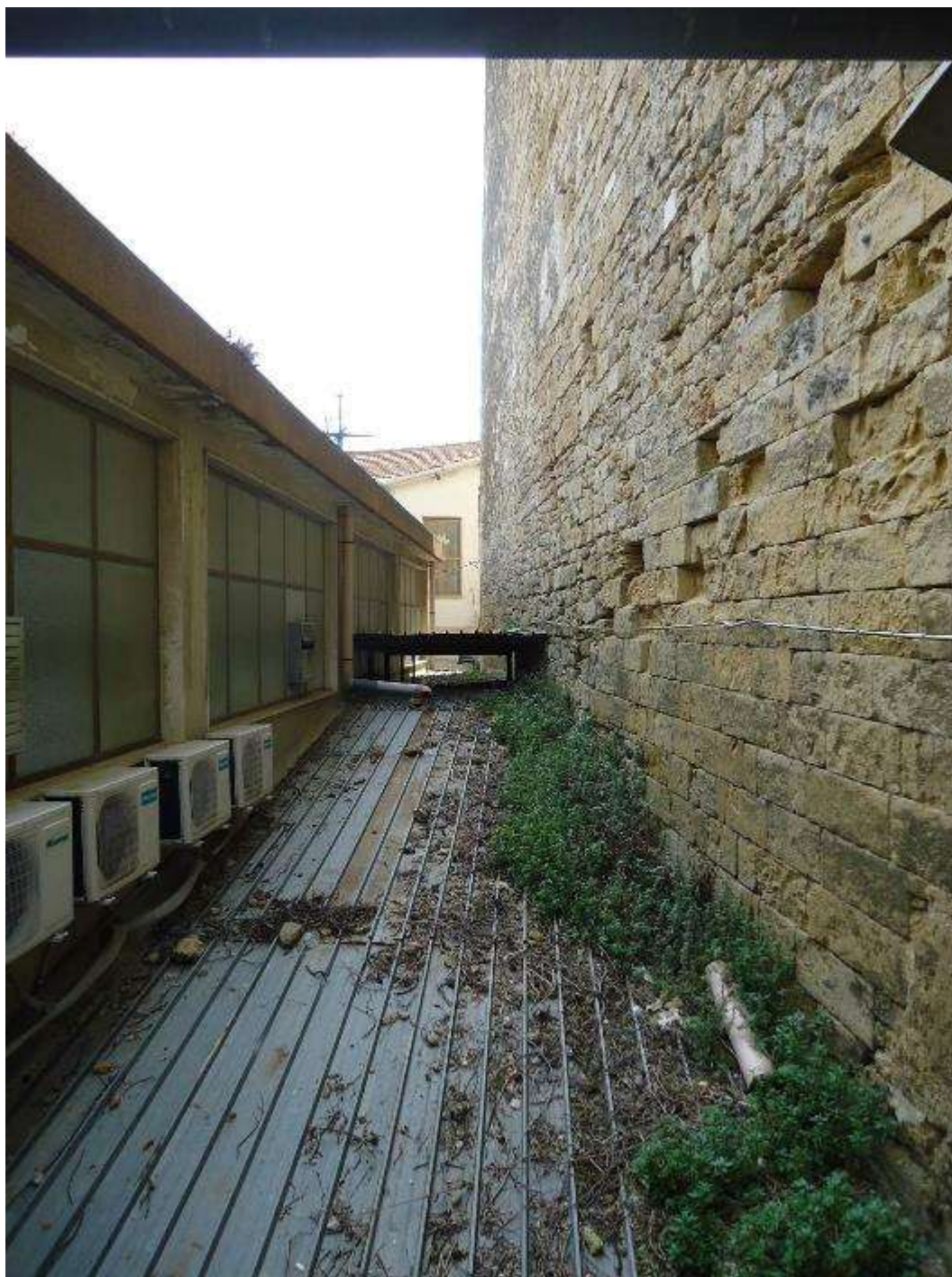
Fig. nr. 19: Copertura in lamiera del corpo di fabbrica alla base del prospetto Nord
