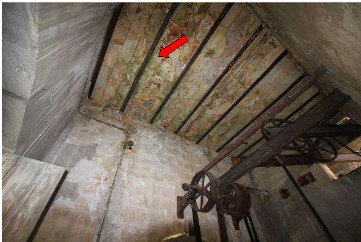
Fig. nr. 39: Intradosso del solaio in putrelle e voltine del vano ascensore siluri
