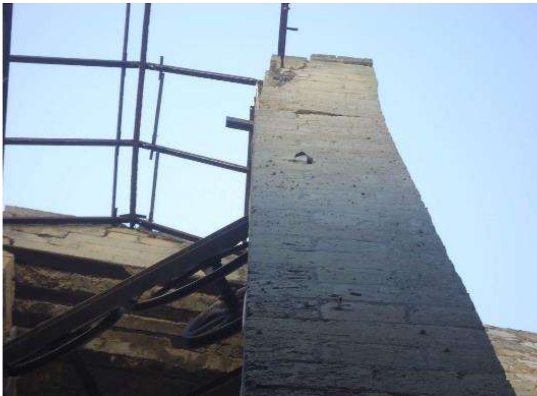
Fig. nr. 36: Sommità della colonna in muratura instabile
