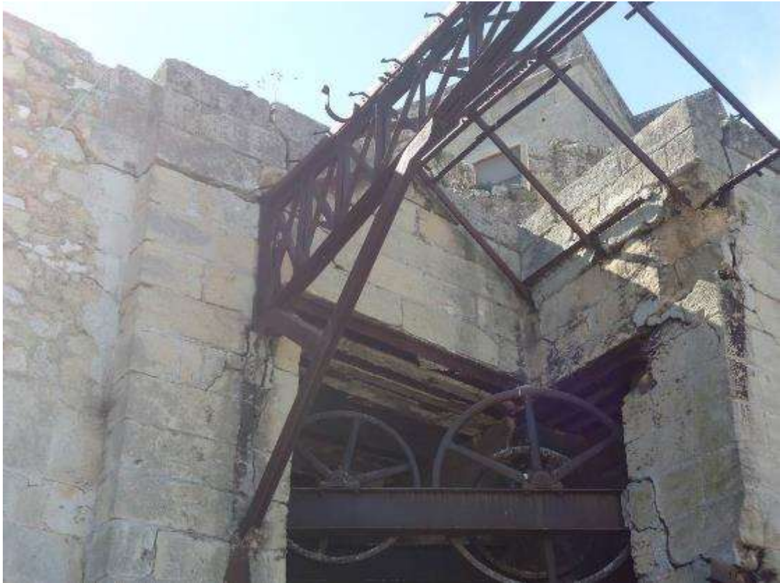
Fig. nr. 35: Sistema di elevazione esterno dell'ex ascensore siluri e munizioni
